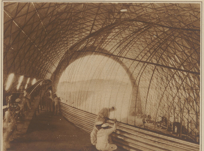
Amerikas neuestes «Luftschiff». Der Bau der «City of Glendale», des in Kalifornien konstruierten Ganz-Metall-Luftschiffes, schreitet mächtig fort. Wie unser Bild zeigt, verwendet man sogar für die Hülle gewelltes Duraluminium. Das Luftschiff kann 40 Passagiere aufnehmen und soll dem Verkehr zwischen New York und Los Angeles dienen
