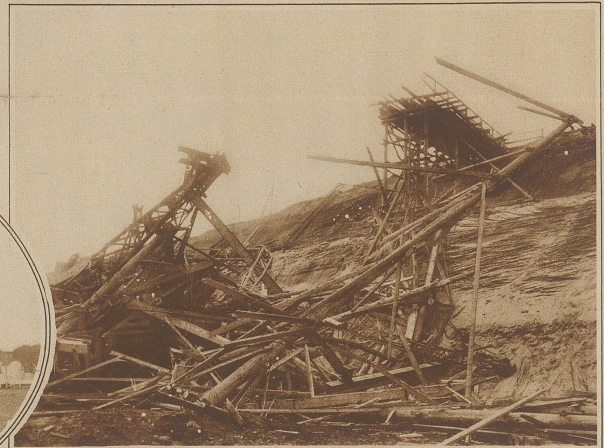
Einsturzkatastrophe in der Lausitz. Ein Orkan riß letzte Woche bei Costebrian die im Bau befindliche 75 m hohe und 400 m lange Abraumförderbrücke eines Kohlenbergwerkes ein, wobei 13 Arbeiter getötet wurden
