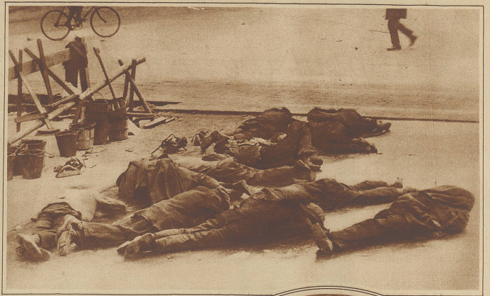
Nicht etwa eine Szene aus dem Bürgerkrieg in Kanton, sondern Asphaltarbeiter, die ihre Mittagspause auf einer Budapester Straße schlafend verbringen
