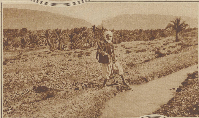
Eine Bewässerungsanlage in der Umgebung der Oase Biskra
