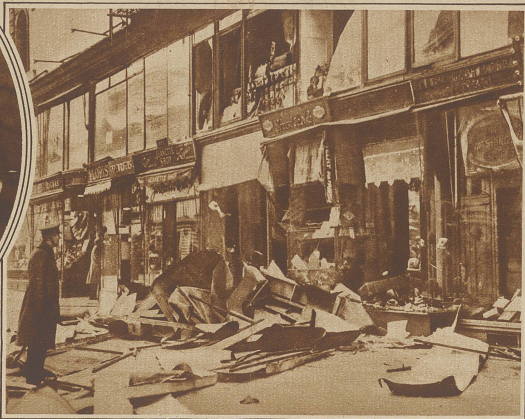
Sturm über New York. Ein gewaltiger Orkan brauste kürzlich über die Riesmetropole und richtete für mehrere hunderttausend Dollar Schaden an. Unser Bild zeigt die verwüsteten Läden in einem der belebtesten Geschäftsviertel.
