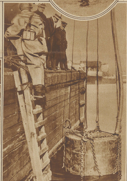
Um den nächsten U-Bootkatastrophen nicht wieder gänzlich hilflos gegenüberzustehen, hat man in Amerika eifrige Versuche gemacht, die zunächst dazu dienen sollen, die Taucher lange auf dem Meeresgrund zu halten und die Rettungsarbeiten so vor jeder Unterbrechung zu schützen. Zu diesem Zwecke arbeitet man mit einem riesigen zylindrischen Tank, in dem die Taucher auf den Meeresgrund hinabgelassen werden. Durch Zuleitungsrohre können ihnen während der Arbeit Luft und Nahrungsmittel zugeführt werden.
