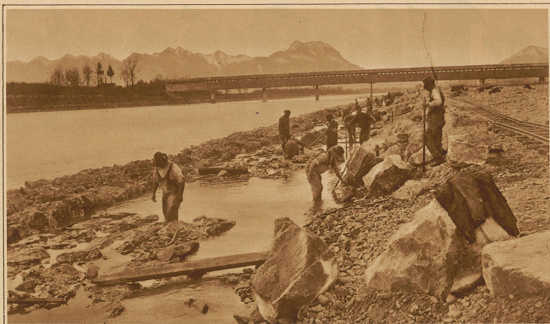
Erstellen des Damms auf dem Schweizerufer. An den Arbeiten sind gegenwärtig 250 Mann beschäftigt. Im Hintergrund die Brücke von Montlingen
