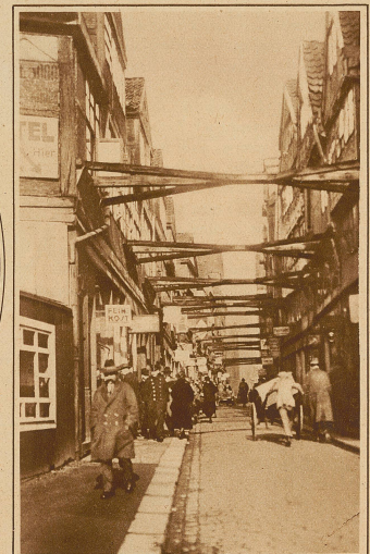
Ein eigenartiges Straßensbild. Eine Straße in Alt-Hamburg, deren Häuser durch Verstreubungen gegen Einsturz geschützt werden
