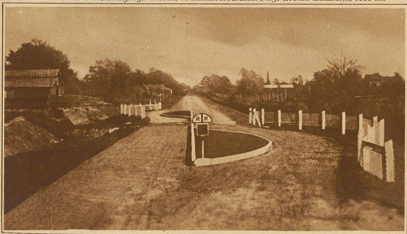
Ein praktischer Schutz für Automobilisten an Bahnübergängen. Die Stadt Collondale in Florida hat zur Vermeidung von Unfällen an Bahnübergängen eine neuartige Anlage geschaffen. In der Mitte der Landstraße ist zu beiden Seiten der Geleise eine halbkreisförmige Raseninsel angelegt, so daß der Fahrer nicht im schnellsten Tempo geradeaus fahren kann, sondern sein ganzes Augenmerk auf dieses Hindernis legen muß
