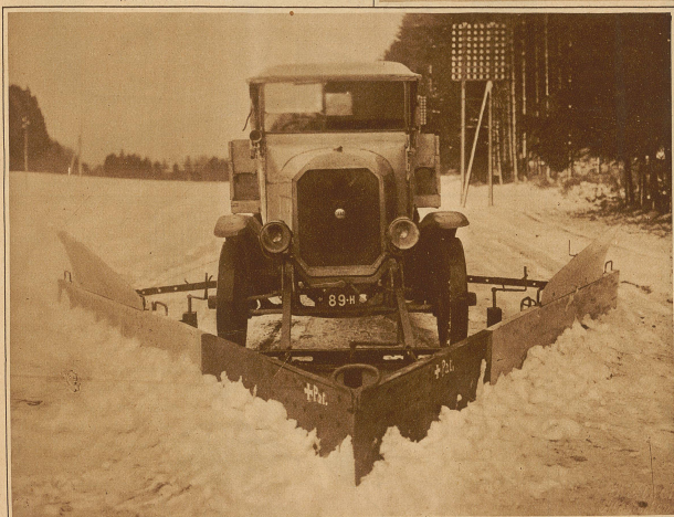
Ein neuartiger, durch einen Lastwagen angetriebener Schneepflug, der letzte Woche anlässlich einer Probefahrt die Strecke Zürich-Unter-Weiskönig.
