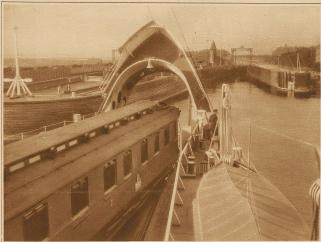
Die Ankunft in Gjedser. Die Spitse des Schiffes wird gehoben, um dem Zug die sofortige Ausfahrt zu ermöglichen
