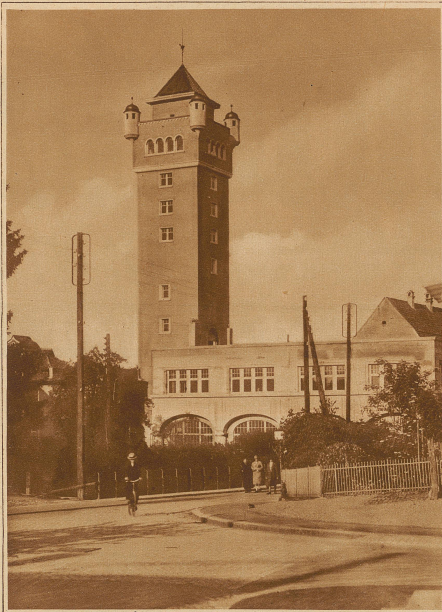
Ein originelles Fabrikamin, das inmitten des Städtchens Arbon errichtet wurde und eine Wohnung, eine Aussichtsterrasse, ein Hochdruck-Wasserreservoir und einen Lift enthält Phot. Burkhardt
