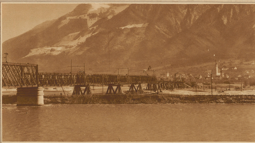
Am Donnerstag ist nun der Verkehr über die fertiggestellte provisorische Eisenbahnbrücke Buchs-Schaan wieder aufgenommen worden, nachdem vorher eine Belastungsprobe mit zwei schweizerischen Dampflokomotiven von 108 bzw. 198 Tonnen Dienstgewicht durchgeführt worden war. Das Bild zeigt die auf Holzapfeln ruhende provisorische Brücke Phot. Biegler
