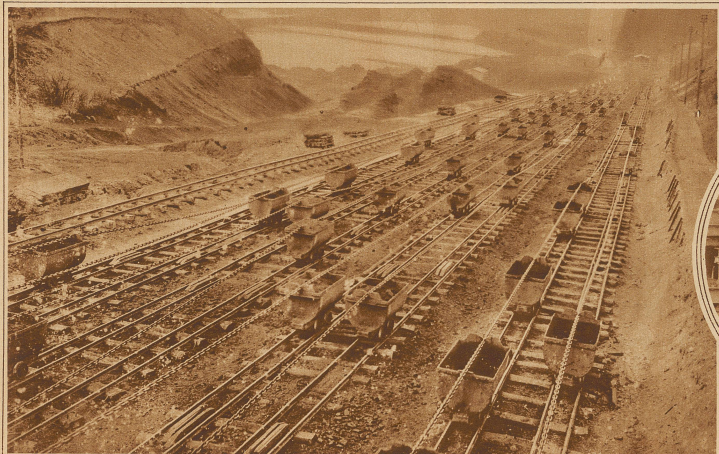
Blick von einer Brikettfabrik auf die stillgelegte sogenannte «schiefe Ebene» mit der vierfachen Kettenbahn, die dem Tagebau die leeren, der Brikettfabrik die mit Kohle beladenen «Hunde» zuführt
