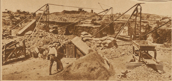
Die Grabungen auf den Feldern von Lichtenburg. Durchsuchen und Sieben des edelsteinhaltigen Sandes
