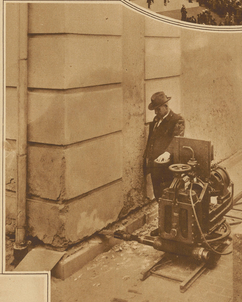
Die neueste Errungenschaft auf dem Gebiete der Technik ist die von einem Münchner Baumeister erfundene elektrische Mäuersäge, die dazu dient, Wasser ziehendes, durchfeuchtetes Mauerwerk zu ebener Erde durchzuschneiden, so daß in die Schnittfluge eine Isoliermasse eingegossen werden kann. Auf diese Weise können Häuser, ohne Belästigung der Bewohner, vor dem Hausschwamm gesichert werden
