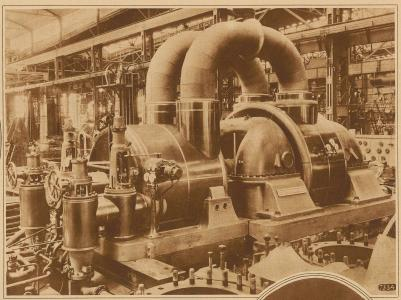
Eine neue zweigehäusige, 4000 P.S Zoelly – Dampfturbine modernster Bauart, wie sie von der Firma Escher Wyß für das Straßburger Elektrizitätswerk geliefert wurde
