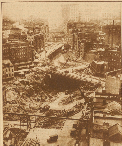
Auch New York reißt seine Straßen auf. Das Bild zeigt einen anschaulichen Blick in die Baugruben einer neuen Untergrundbahn, die mitten in der City New Yorks längs der 6. Avenue gebaut wird
