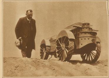
Modell eines Wüstenschiffes für Transport» und Forschungszwecke in Wüsten und Steppen. Das Fahrseug wird durch zwei Diesielmotoren angetrieben und ist mit dem modernsten Kom-tor ausgestattet. Neben dem Modell der Erfinder Ingenieur Bischoff
