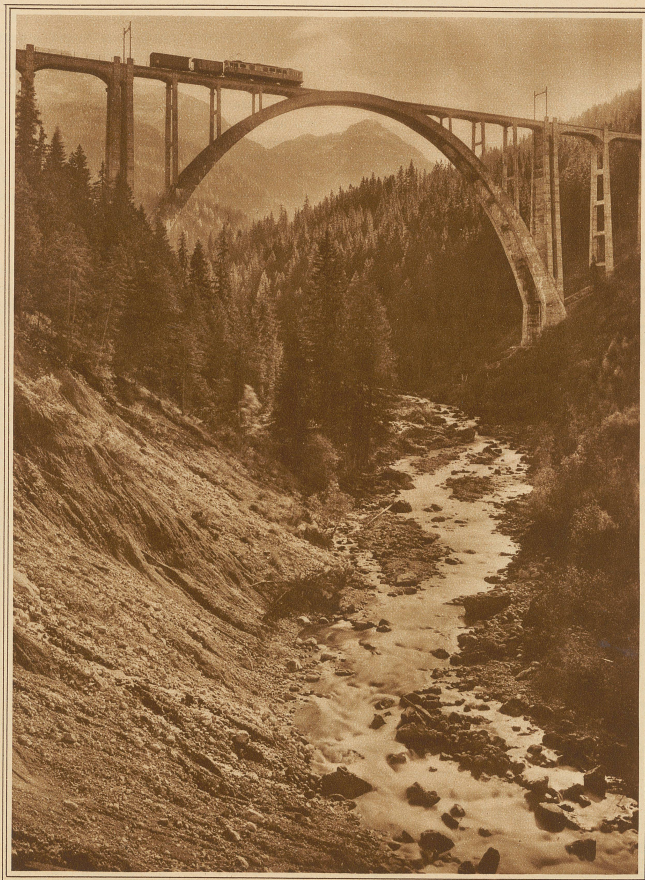
Der Langwieser Viadukt der Chur-Arosa-Bahn
