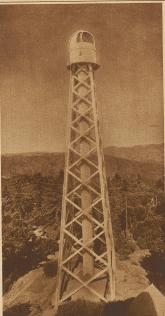
Turmteleskop der Mt.Wilson-Sternwarte in Kalifornien Das eigentliche Fernrohr steht senkrecht in der Mitte des Turmes. Durch ein in der Kuppel betindliches Spiegelpaar wird das Licht dem Instrument sugsführt. Die Beobachtungsräume liegen gleichmäßiger Temperaturen wegen in Kellersewölben. Dieses Turmteleskop eignet sich besonders für Sonnen-beobachtungen
