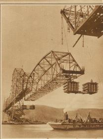
Die Gewalt der Technik. Die neue Eisenbahnbrücke über die Carquiney «Streaits» an der San Francisco Bay, die jetst ihrerVollendung entgegengeht. Unser Bild zeist das Einfügen des Mittelstückes
