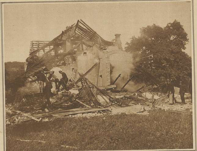
In den Bronzefabrikwerken A.-G. in Kempen bei Weiskon, ereignete sich durch Entzündung von Aluminiumstaub eine Explosion, die den drei Arbeitern Zuberbühler, Pfaff und Hauser das Leben kostete
