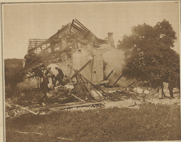
In den Bronzefarwerken A.-G. in Kempten bei Weiskon, ereignete sich durch Entzündung von Aluminiumstaub eine Explosion, die den drei Arbeitern Zuberbühler, Pfaff und Hauser das Leben kostete Eröffnungsfeier der Furka-Oberalpbahn
