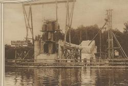
Ansicht eines Tunnelteiles von der Wasserscite Die Versenkung des Müggeltunnels bei Friedrichshagen, der über Wasser vollständig fertig-gestellt und dann als Fußgängertunnel in den Fluß versenkt wurde
