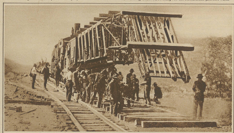
Eine Maschine zur Legung von Eisenbahnschienen. In Amerika benutzt man zum Legen von Eisenbahnschienen eine Lokomotive, die wohl eine der interessantesten Konstruktionen ist, die man sich für eine derartige Arbeit denken kann. Die Lokomotive drückt einen Transporter für Eisenbahnschienen, der sehr große Rollen aus, und läßt die Schienen in gleichmäßiger Abstände auf die Rollen herunterfallen. Der gesamte Transport der Materials sowie der Arbeiter wird durch die Maschine auf selbstgelegten Schienen bewerkstelligt
