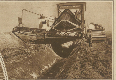
In Omaha (Nebraska U.S.A.) sind riesige Drainage-Maschinen an der Arbeit, die den dortigen sehr alten Boden bis zu einer Tiefe von 1 m unadern und zu blühenden Feldern verwandeln.
