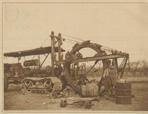
Baggermaschinen zum Ausheben der Gräben für Pipe Lines
