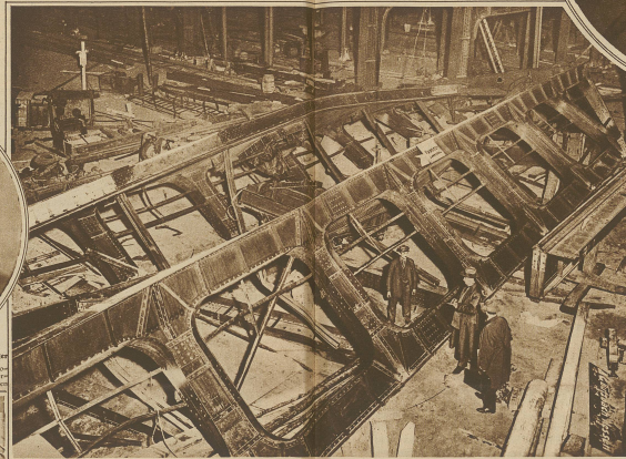
Der eingestürzte Laufkran des Kraftwerkes Rummelsburg.
