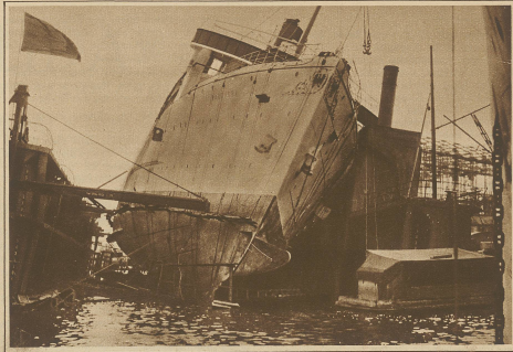
Das im Schwimmdock von Stettin liegende Fabrikschiff 'Preußen' liegt während der Reparatur auf die Seite, wobei 2 Mann der Besatzung schwer verletzt wurden.
