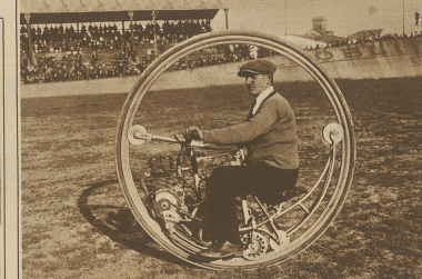
Nach längeren Versuchen ist es dem italienischen Ingenieur Davigo endlich gelungen, diese scheinbar unmögliche Fahrt zu vollziehen, auf so praktische Verwendung finden kann. Das Einmal hat einen Durchmesser von 175 cm und wird durch einen Viertaktmotor vorwärts bewegt.
