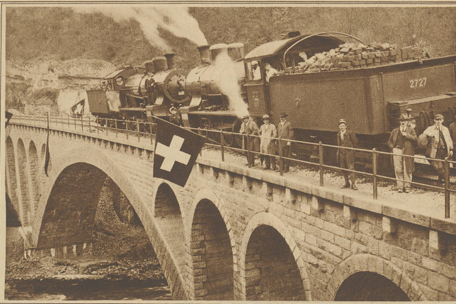
Die untere Brücke während der Belastungsprobe
