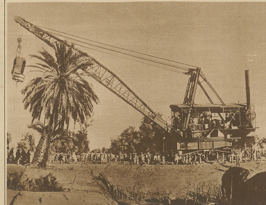
Ansicht eines Steinbagers, wie er zur Arbeit der indischen Wägenbahn verwendet wird. Der Bagger speichert an einem Tage eine Arbeit, die gewöhnlich die Leistung von zwei Arbeitern entspricht. Mit einem einzigen Hub vermag die Maschine 8 Tonnen Erdbreich auszuheben
