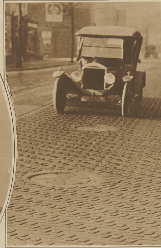
Communistenpöbel in England. Zum Schutz gegen das Schändern der Autenobile ist in Acton, in der Nähe Londons, eine neuartige Straßenpflasterung gelegt worden, die sich bisher aussergewöhnlich bewährt. Das Pflaster besteht aus kleinen Holzböcken, die mit Gummirollen belegt sind
