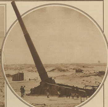
Die größte Kanone der Welt befindet sich im Fort Tilden bei New York und dient zur Küstenverteidigung. Die See- und Luftschiffe mit 12 Zoll und das Geschütz ist imstande, Geschosse von 34 Zentnern Geschosse abzufeuern
