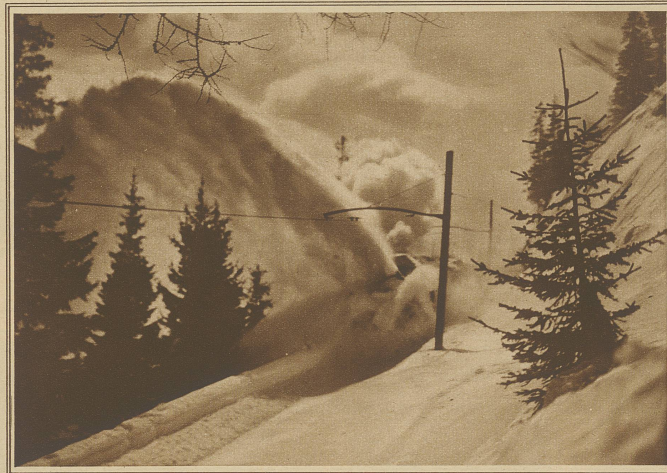
Schneeschleudermaschine der Berninabahn in voller Tätigkeit
