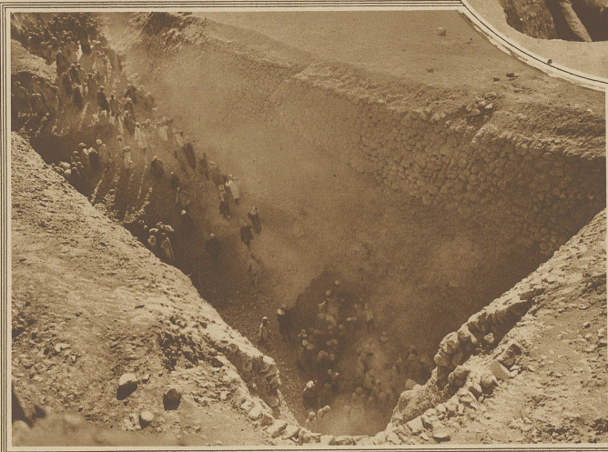
Der Eingang zum Grabe des Königs Mentuhotep, das «Bab el-Hosan», aus dem die eingeborenen Arbeiter den Sand herausheben
