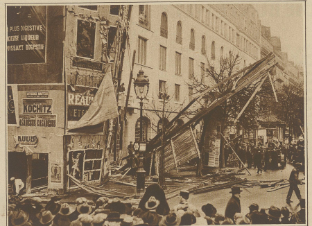
Schwere Unwetterschäden in Frankreich. Unser Bild zeigt eine an einem Neubau auf den großen Boulevards in Paris errichtete Gerüstwand, die vom Sturm auf die Straße geworfen wurde und den starken Verkehr für längere Zeit unterbrach
