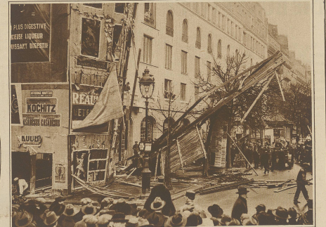
Schwere Livwetterschäden in Frankreich. Unser Bild zeigt eine an einem Neubau auf den großen Boulevards in Paris errichtete Gerüstwand, die vom Sturm auf die Straße geworfen wurde und den starken Verkehr für längere Zeit unterbrach
