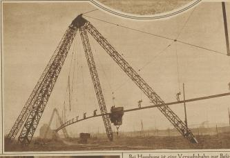
Bei Hamburg ist eine Versuchsbahn zur Beförderung von Lastkähnen erbaut worden. Die Kähne werden durch einen auf einer Schwebeschiene laufenden Motor gezogen
