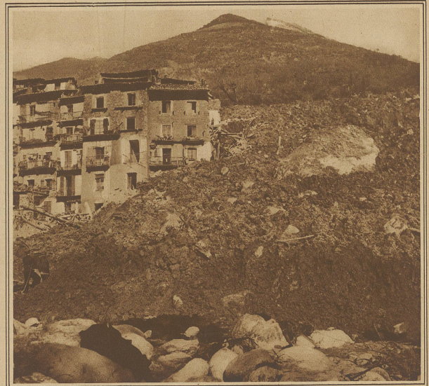
Grabungen nach Verschlütteten im westlichen Teil des Absturzgebietes
