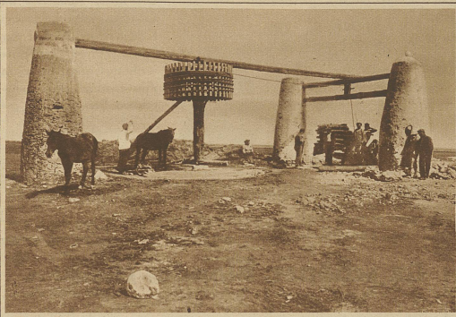
Eine eigenartige Brunnenanlage auf einem jüdischen Siedlungsgelände in Südrussland. Das Pferd treibt die senkrecht stehende Welle und hebt dadurch den großen Wassereimer aus dem 80 Meter tiefen Sod
