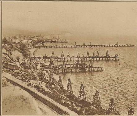
Die merkwürdigsten Ölfelder der Welt befinden sich in Summerfield zwischen Santa Barbara und Los Angeles in Kalifornien. Die Felder liegen auf dem Meeresgrunde, so daß das Öl durch spezielle Brunnen und Anlagen herausgepumpt werden muß. Unser Bild zeigt einen Teil dieser Anlage.
