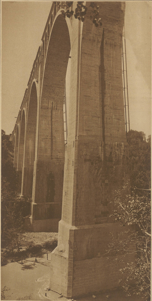
Bild links: Ansicht der mächtigen Pfeiler, die auf die verstärkten Fundamente der alten Brücke aufgebaut wurden
