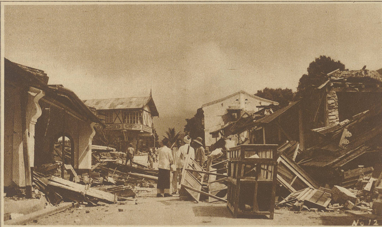
Eine Dorfstraße in Padang-Pandjang, wo die größten Verheerungen angerichtet wurden
