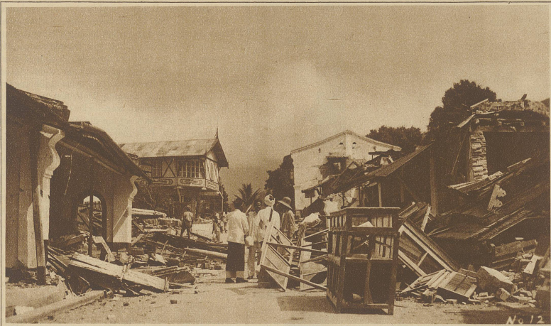
Eine Dorfstraße in Padang-Pandjang, wo die größten Verheerungen angerichtet wurden
