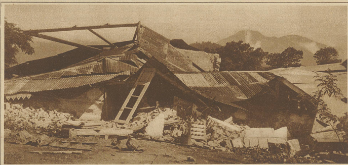
Verwüstungen in einer Straße des Chinesenviertels
