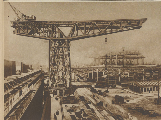
Die größten Drehkrane der Welt befinden sich auf einer Schiffswerft in Hamburg. Der im Bilde ersichtliche Turndrehkran erreicht in hochgehobenem Zustand eine Höhe von über 80 m und ist imstande, 250 Tonnen zu heben
