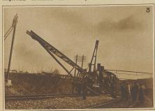
Kranwagen zum Stellen der Maste und einer Anzahl beladener Wagen mit Masten. Wenn diese Komposition dem Unternehmer zur Verfügung gestellt wird, geschieht das Stellen der Maste vermittelst des Kranes. Werden dagegen die Maste, wie erwähnt, mit den kleinen Rollwagen verführt, so müssen sie nachher mit Hilfe von sog.
