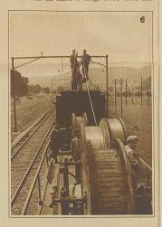
besorgt die Festmachungen, welche eventuell von den beiden vordern aus irgend einem Grunde übersprungen worden sind, weil die Geschwindigkeit des Zuges zu groß war. Wenn nun der Kupfer- oder Fahrdraht, wie man zu sagen pflegt, ausgelegt ist, so folgt das Fertigmachen und Einstellen der Fahrleitung über Schienenoberkant. Der Fahrdraht muß somit genau ausregliert werden und wird zudem bei jedem Träger durch eine sogenannte Spurhaltung in seiner Lage fest-
