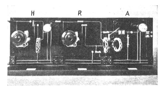
Fig. 49. Rückkopplungsaudion mit Hochfrequenzverstärkung. H Lehrmodell "Hochfrequenz". R Lehrmodell "Resonanz". A Lehrmodell "Audion".
