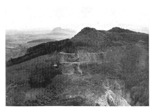
Hohenstoffeln, von Norden, mit dem Basaltbruch in einem frühen Stadium des Abbaus. Im Vordergrund oben Süßwassermolasse, hinten Hohentwiel und Schienerberg.
