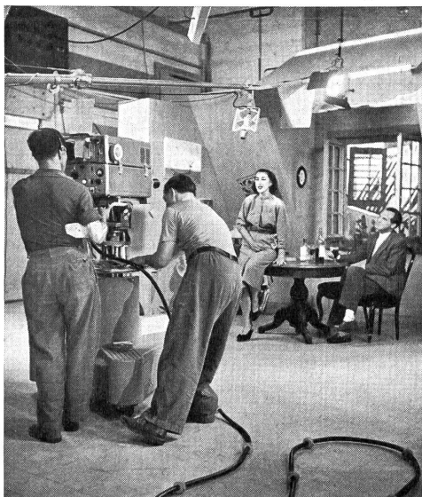
Fernsehaufnahme aus Zürich. Chefkameramann Roetheli an der Arbeit. Oben der Tonarm mit dem Mikrophon. Auffallend, die im Verhältnis zu Filmaufnahmen geringe Beleuchtung. Fernsehkameras sind viel lichtempfindlicher als Filmkameras. (Photo G. Züst.)
