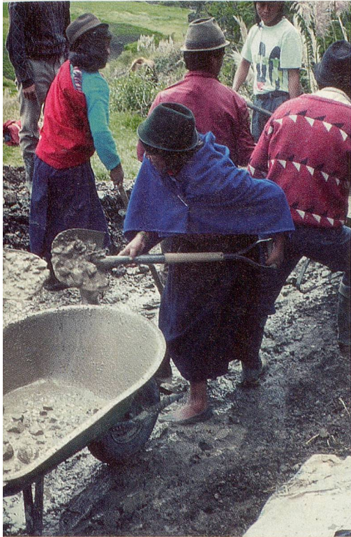
Bauarbeiten an einer Wasserleitung in Mulallilo, Ecuador.
