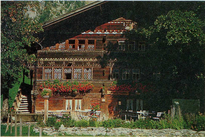
Heute Landgasthof: Das Ruedihus in Kandersteg ist eines der ältesten Gebäude der Gemeinde.
