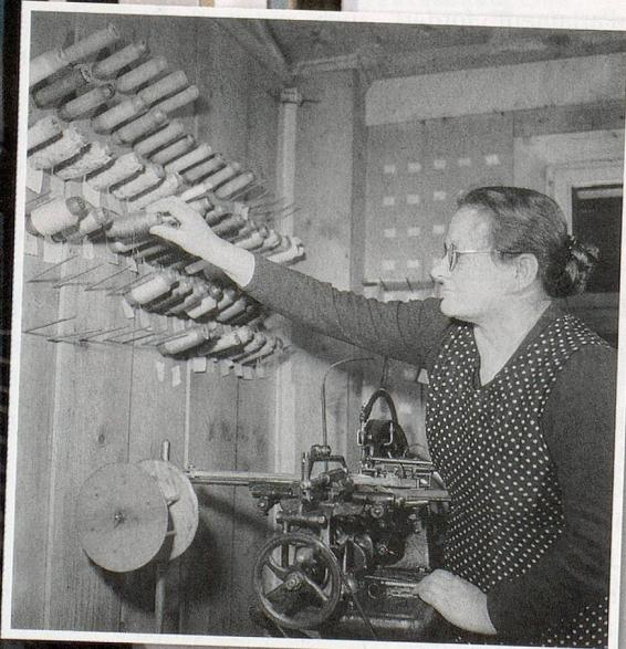
den Wagen mit den Nadeln in Bewegung, sie durchstechen die Stofftüchlein und werden auf der Rückseite von den gleich angeordneten Klappern in Empfang genommen. Es ist dieselbe Bewegung wie bei der Handstickerei: Die Nadeln werden durch den Stoff hindurchgestochen und wieder zurückgeholt.
