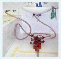
Nach der Rohr-Reinigung erfolgt die Innenbeschichtung der Wasserleitungen mit Epoxydharz.
