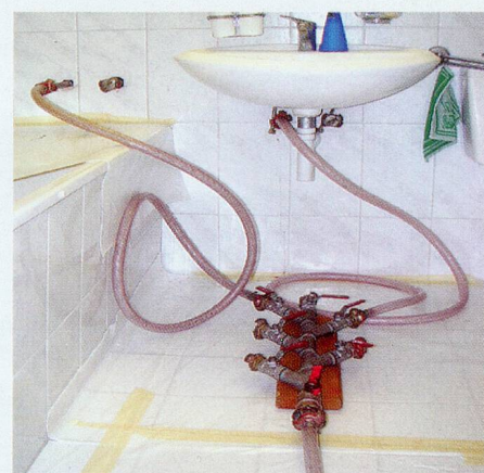
Nach der Rohr-Reinigung erfolgt die Innenbeschichtung der Wasserleitungen mit Epoxydharz.
