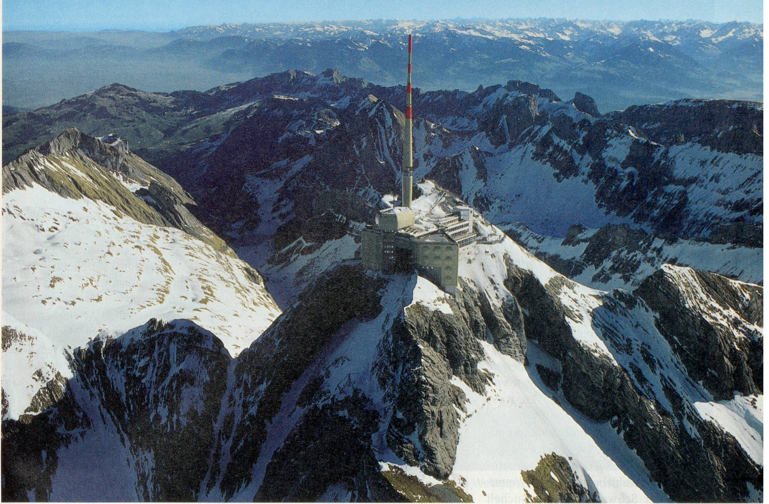
Der Arbeitsplatz auf dem Säntisgipfel mit dem Antennenturm: Natur und Technik kommen auf dem Wetterberg zusammen.
