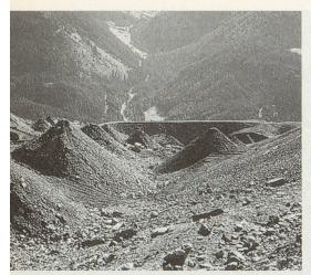
Die Bremshöcker im Gelände stoppen die Lawine, der Auffangdamm hält die Schneemassen auf. Foto: SLF
