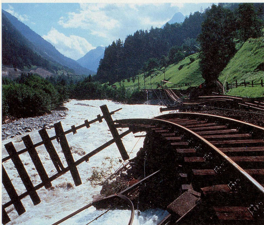
Am 23./24. August 1992 führte anhaltender starker Regen zu Überschwemmungen im Kanton Uri. Dabei unterspülte die Reuss die Gotthardbahnlinie.
